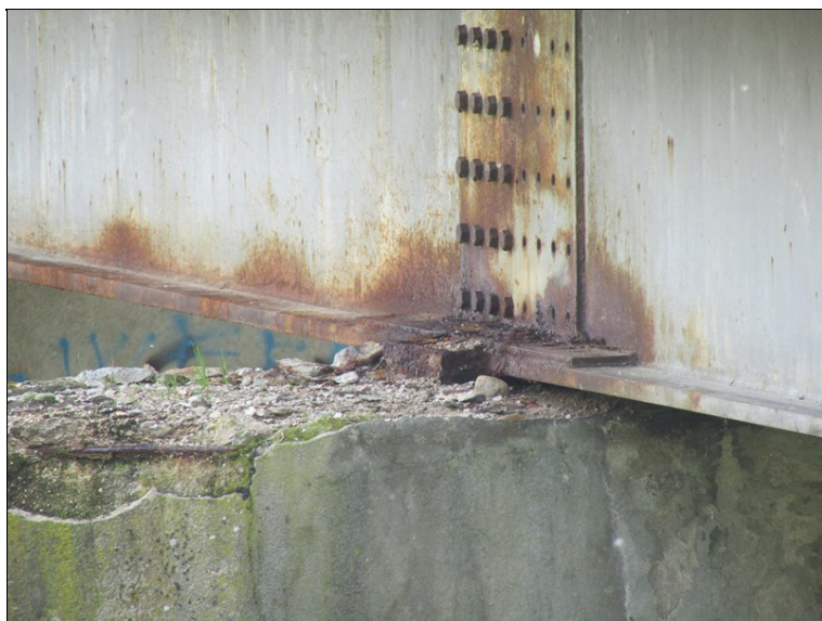
Koroze ložiska a dolní pásnice nosníku na pilíři
