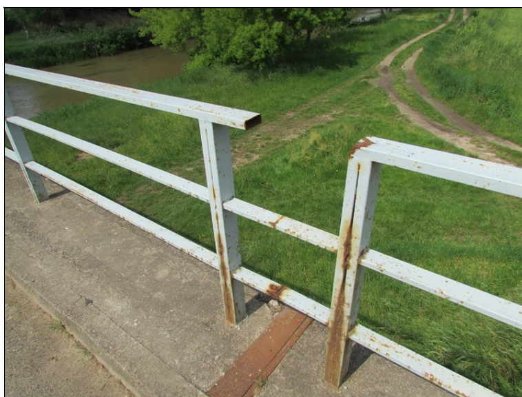
Chybějící madlo levého zábradlí u opěry 4
