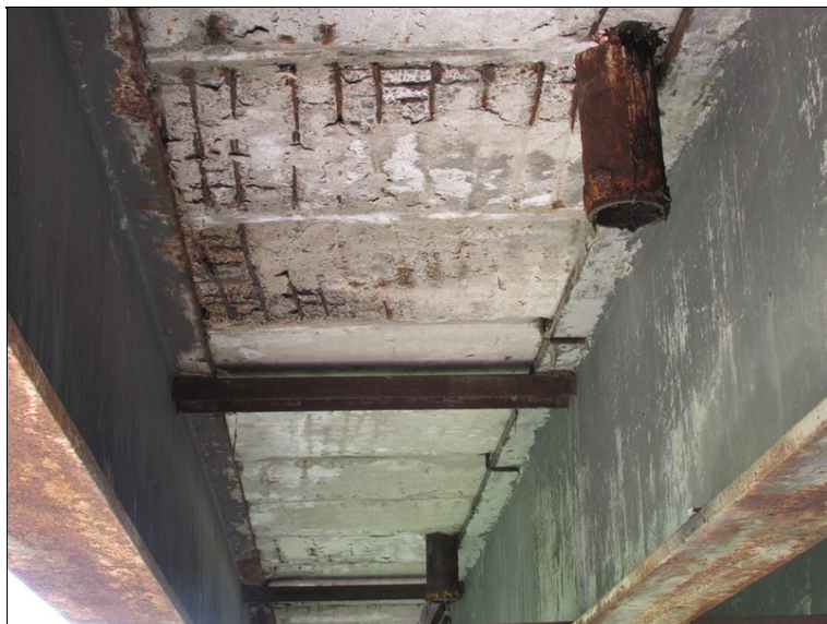
Obnažená korodující výztuž v podhledu NK, koroze odvodňovačů
