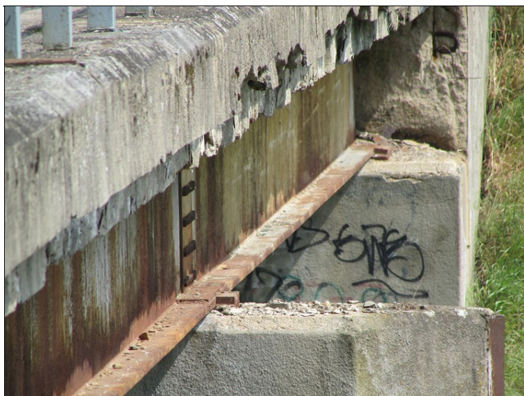
Degradace římsy
