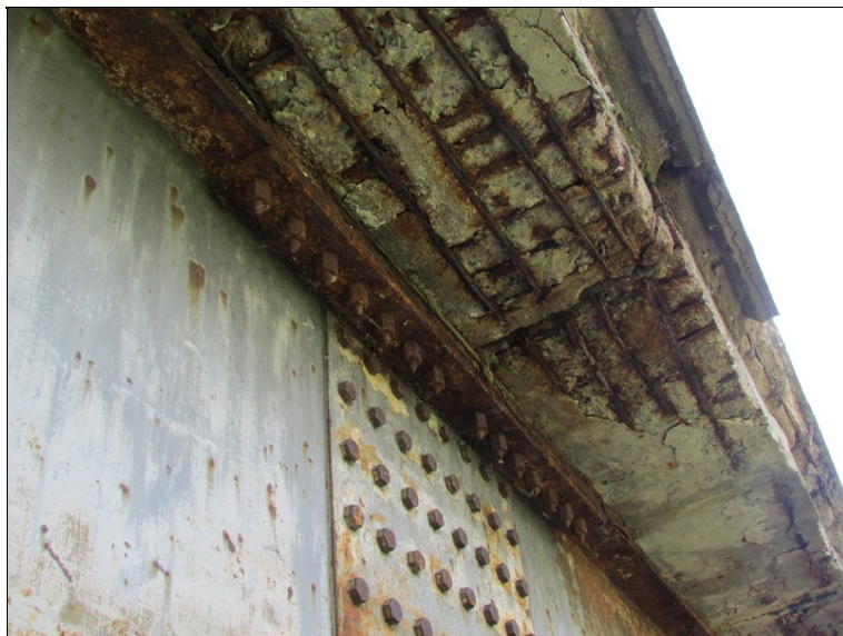
Degradace betonu, koroze výztuže a horní pásnice nosníku v krajní části NK
