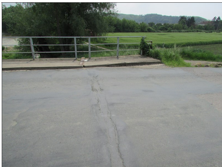
Příčné trhliny v místě mostního závěru u opěry 1
