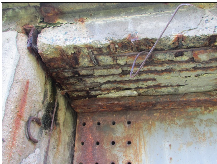
Degradace betonu desky a závěrné zídky, silná koroze výztuže, uvolněná výztuž
