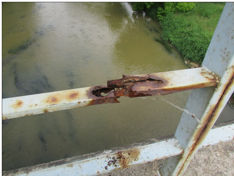
Zcela zkorodované madlo zábradlí v místě montážního styku zábradlí, madlo je uvolněné
