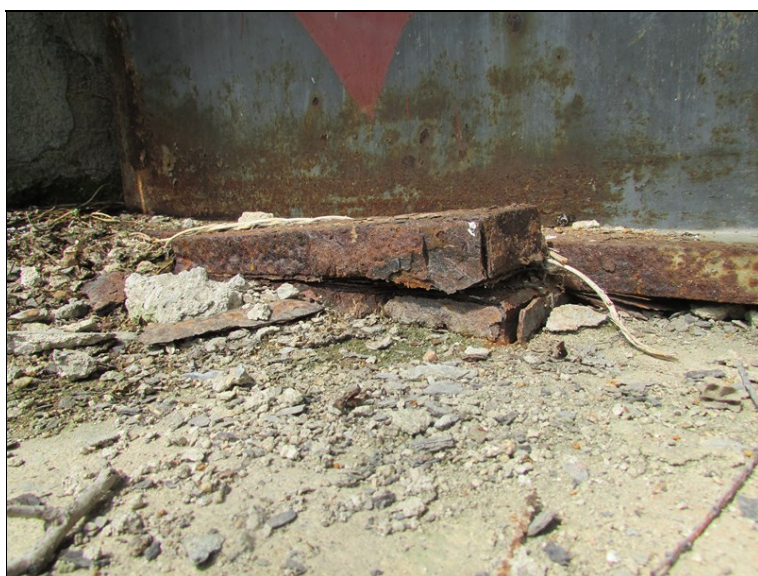
Odlomená vodící lišta krajního nosníku na opěře 1, nečistoty na úložném prahu
