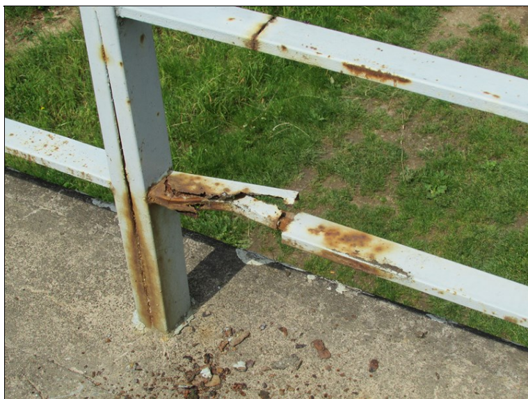
Zkorodované madlo zábradlí
