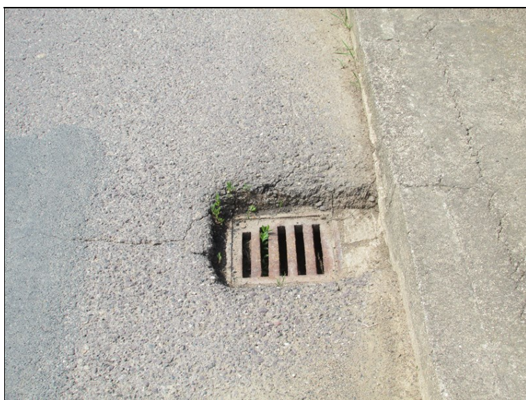
Odvodňovací vpust' utopená v převrstvené vozovce
