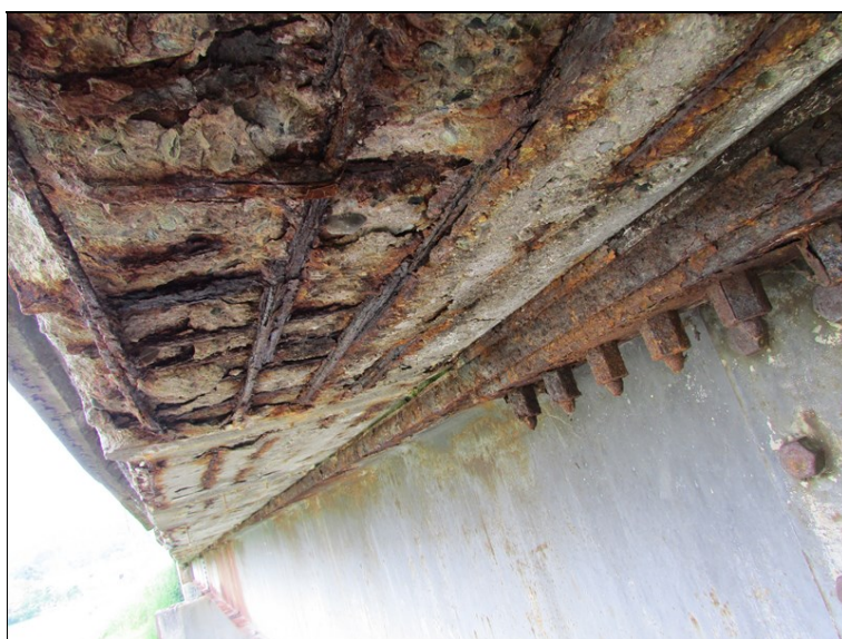
Koroze výztuže a horní pásnice krajního nosníku nad pilířem 2
